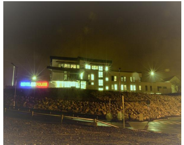
Le nouvel hôtel de police de Longwy-Mont-St-Martin, ouvert le 20 décembre 2016 : une belle réalisation pilotée par la direction de l'immobilier du SGAMI Est
